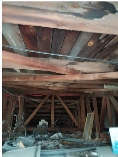
Střešní konstrukce – příhradové vazníky
