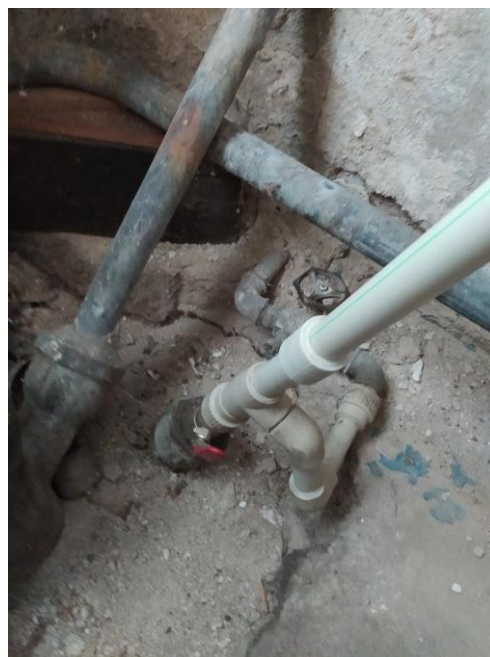
Napojení na topný kanál a vodovodní přípojka a napojení kanalizace
