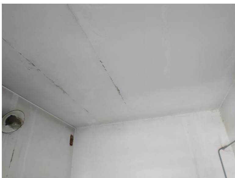
Stropní (střešní) panel a viditelné spoje panelů
