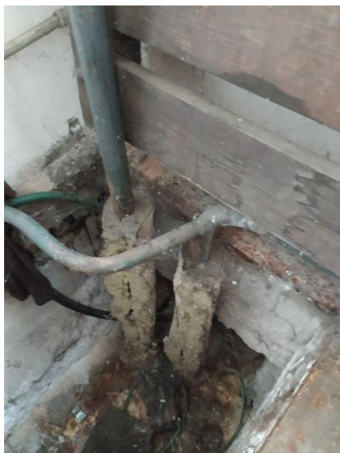
Napojení na topný kanál a vodovodní přípojka a napojení kanalizace
